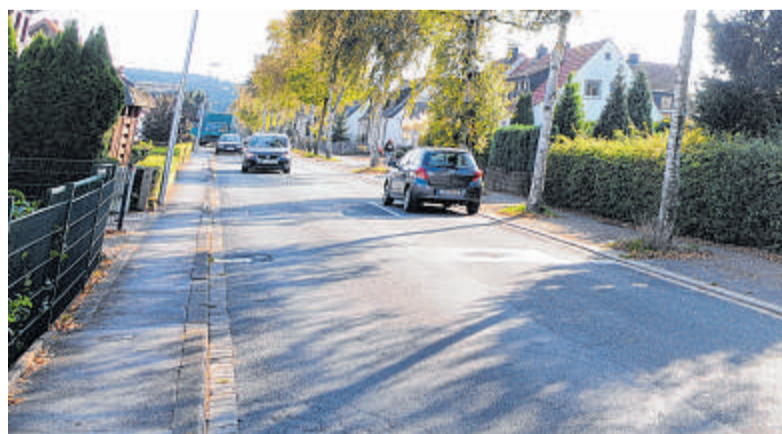
Die Hermann-Löns-Straße: Hier entsteht ab Montag für vier Monate eine Baustelle, in den ersten sechs Wochen mit Vollsperrung.
